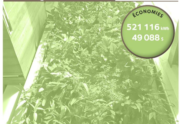
Un mur végétal est aménagé pour permettre le passage de l'air vicié du bâtiment à travers le réseau racinaire des plantes sur lesquelles vivent des microorganismes, capable de décomposer certains polluants en substances bénignes. Outre ses fonctions biofiltrantes, le mur végétal offre d'autres avantages, comme l'indiquent les données suivantes, générées en temps réel par les outils de mesure du bâtiment.
