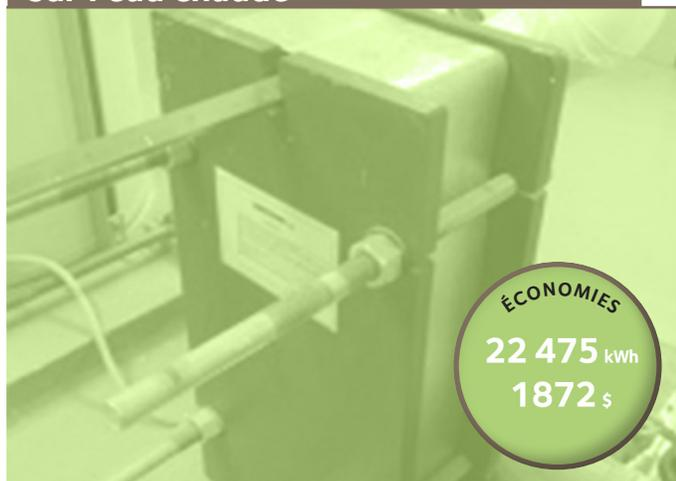
La chaleur produite par le système de climatisation, lorsqu'elle n'est pas utilisée pour chauffer le bâtiment, est transférée à l'eau chaude domestique.
