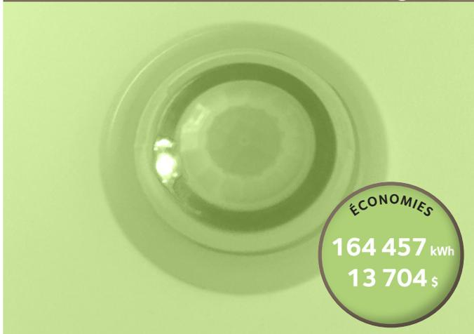
Dans les bureaux fermés et les salles de réunion de la MDD, des détecteurs de mouvement allument et éteignent les luminaires. Dans certains locaux situés du côté ouest, des détecteurs de luminosité éteignent automatiquement les appareils lorsque la lumière naturelle est suffisante.
